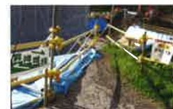
現場仮設として
