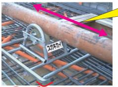
ローラーにて配管の前後への動きを流してスパイダー本体を不動にする事で鉄筋の乱れを大幅に軽減!
