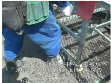
⑦中央部の取手を持ち、天板が水平になる様に行き止り(中央のロックピンB(4ヶ所)がカチッと音がなるまで)回します
