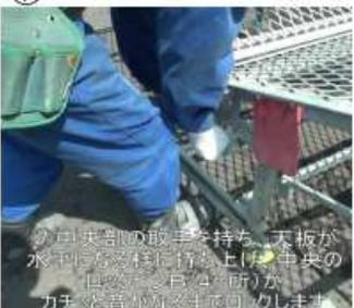
⑦中央部の取手を持ち、天板が水平になる様に行き止り(中央のロックピンB(4ヶ所)がカチッと音がなるまで)回します
