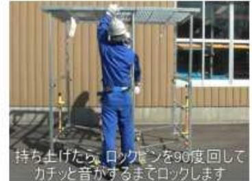
持ち上げた後、ロックピンを90度回してカチッと音がるまでロックします
