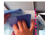
母材(採光防音シート)の横面を合わせてからターボリンを被せて天井⇔壁を接合。
