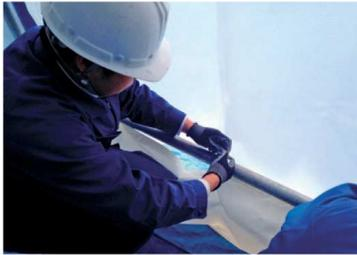
骨組み下部横地へスカート材を紐固定する。
