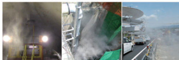
コンクリート養生
